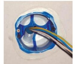
Lorsque l'étanchéité du fourreau est impossible, utiliser un mastic d'étanchéité spécifique sans silicone et sans COV.
